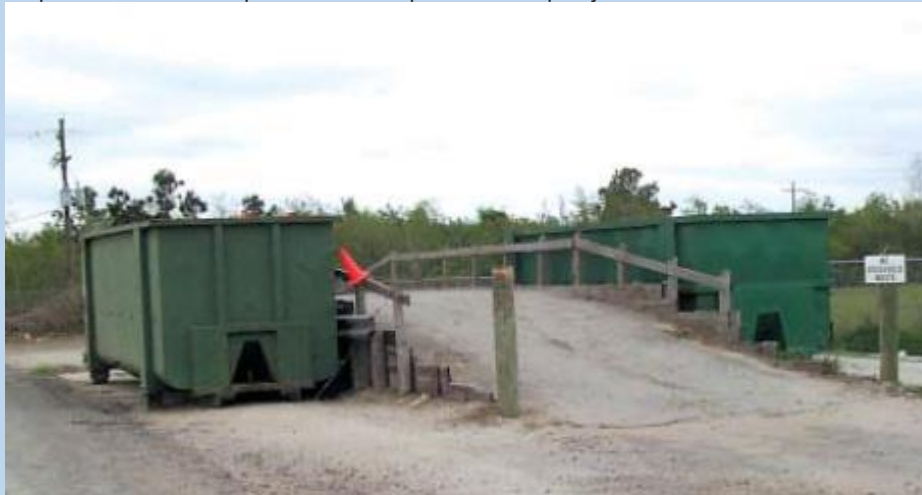
Slika 19 Ruralna stanica za prenos otpada, Chamber County, Texas
