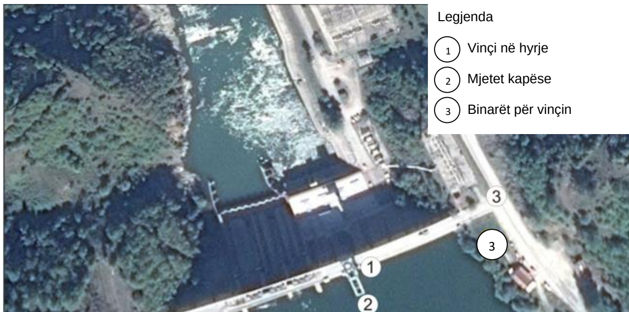
Figura 29 Pajisje e instaluara për kapjen e mbeturinave lundruese në rezervuarin Potpec (lumi Lim)
